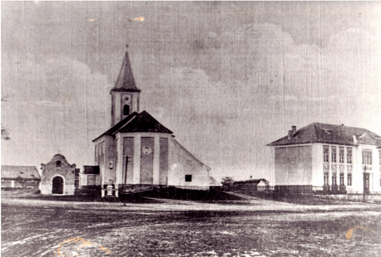
Alte Kirche: 1724 (Grundsteinlegung) bis 1937
